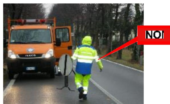
La prima operazione da compiere nell'allestimento del cantiere consiste nel posizionare la segnaletica da entrambi i sensi di marcia al fine di indicare ai veicoli in avvicinamento la presenza del cantiere e degli operai in carreggiata e quindi di delimitare l'area di lavoro. I cartelli sono disposti partendo dalla zona limitrofa e procedendo nella direzione del cantiere stesso, dapprima in un senso di marcia e poi in quello opposto.
