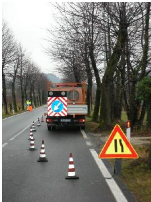
**FASE 4: Rimozione del cantiere:**
