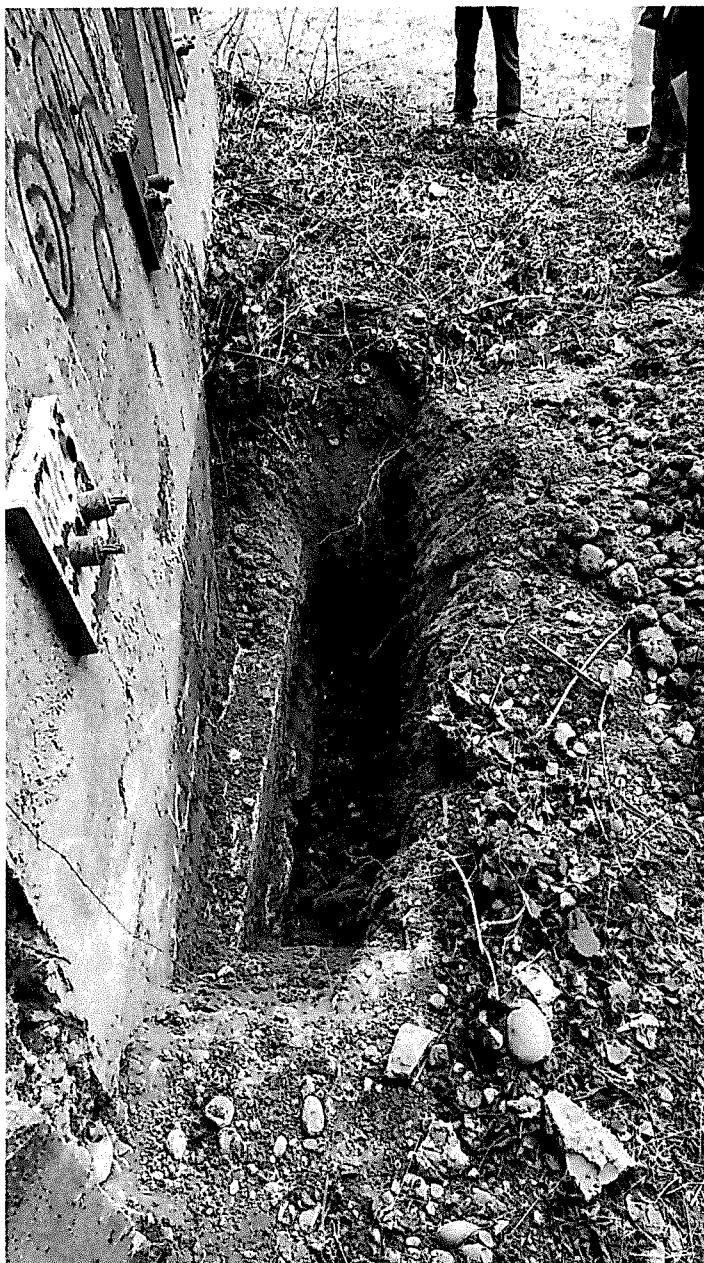
FOTO 3: saggio eseguito in corrispondenza del muro d'ala. Si nota l'esiguità dello zoccolo fondazionale.
