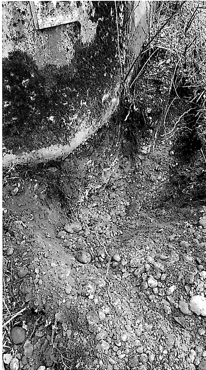
FOTO 3: saggio eseguito in corrispondenza del muro d'ala. Si nota l'esiguità dello zoccolo fondazionale.
